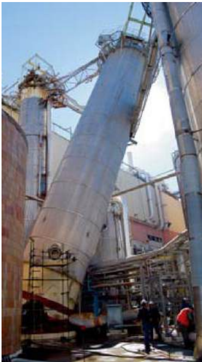
Figure 2.6 - Industrie papetière / Tour de blanchiment - Séisme de Maule, Magnitude 8,8 Chili 2010 [112]
