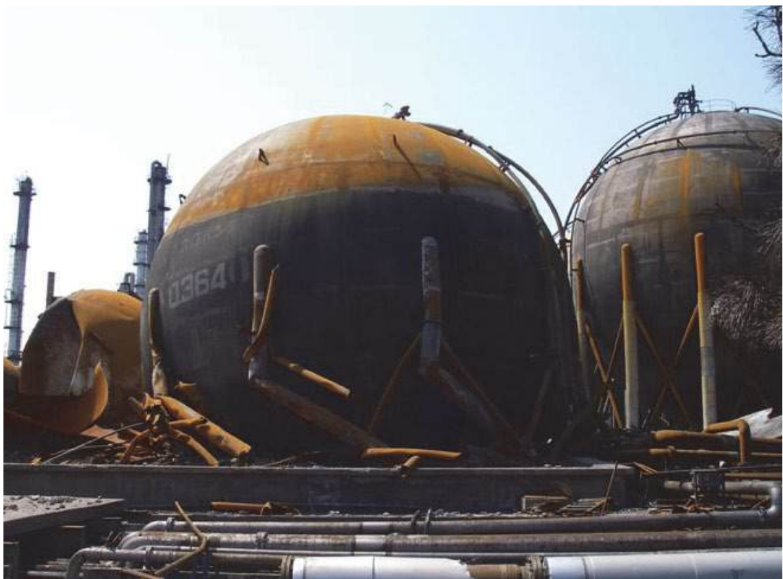
Figure 4.4 : Instabilité (Flambement) des poteaux de supportage d'une sphère [64] Séisme de Tohoku, Magnitude 9 Japon 2011
