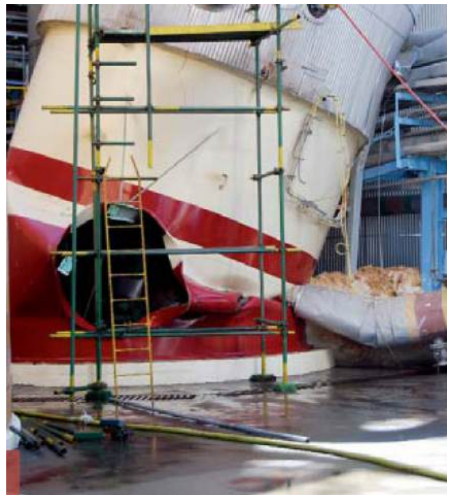
Figure 2.6 - Industrie papetière / Tour de blanchiment - Séisme de Maule, Magnitude 8,8 Chili 2010 [112]
