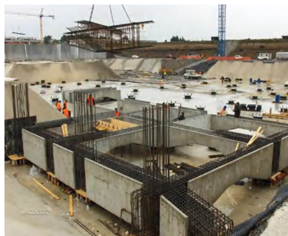
Figure 2-22 : Bâtiment stratégique sur isolateurs et dissipateurs d'énergie (Italie)
