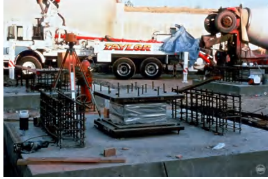
b/ Vue d'un isolateur avant installation
