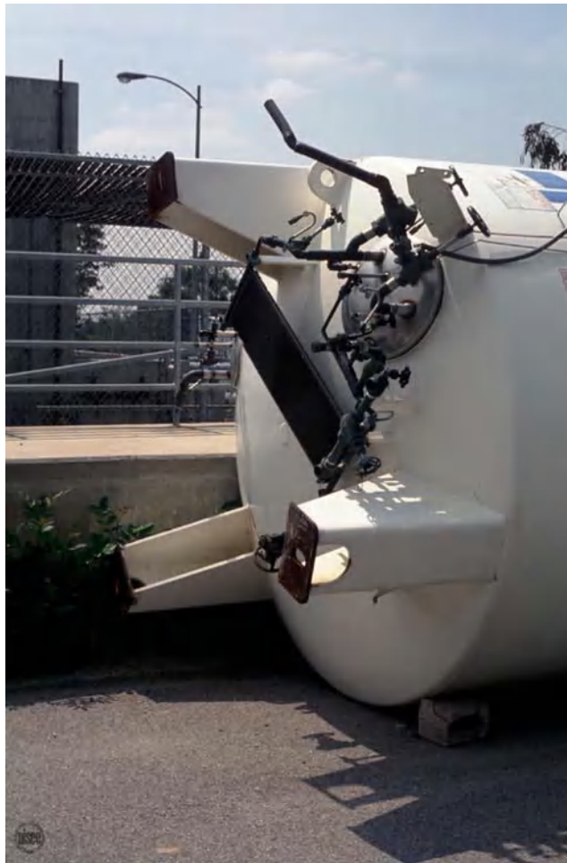
Figure 2-8 : Renversement d'un réservoir suite à une rupture d'ancrage (Northridge, 1994, [R13])
