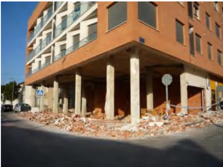
b/ Remplissage en maçonnerie d'un niveau commercial
