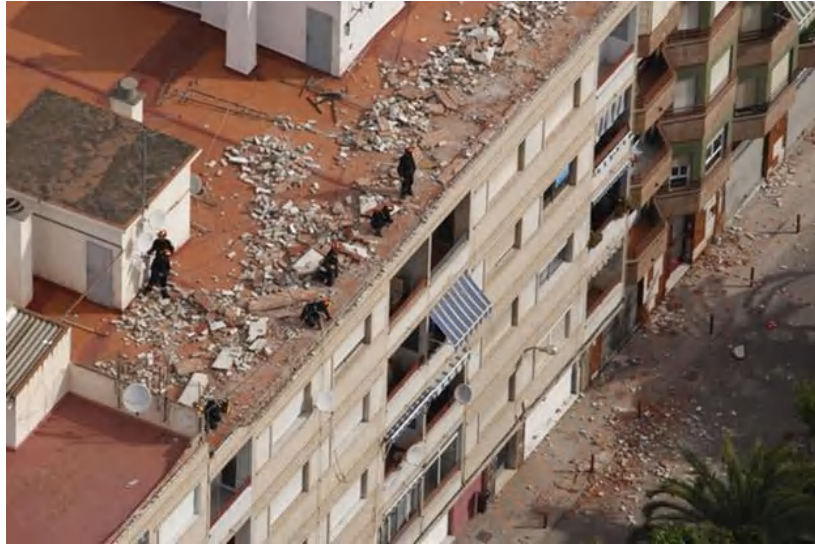
a/ Rambarde de toiture d'un bâtiment d'habitation
