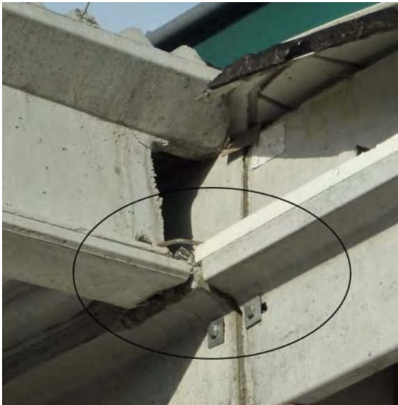
b/ Pannes simplement posées sur des poutres c/ Effondrement quasi-total des dalles de toitures
