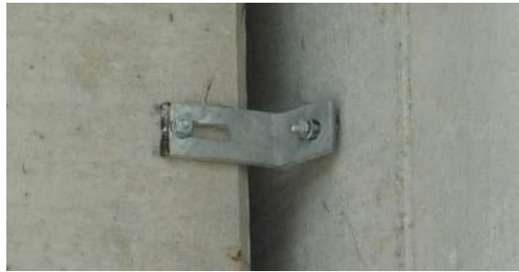
a/ Liaisons d'éléments de façade sous-dimensionnés
