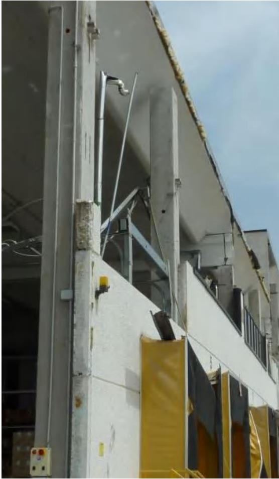
a/ Liaisons d'éléments de façade sous-dimensionnés
