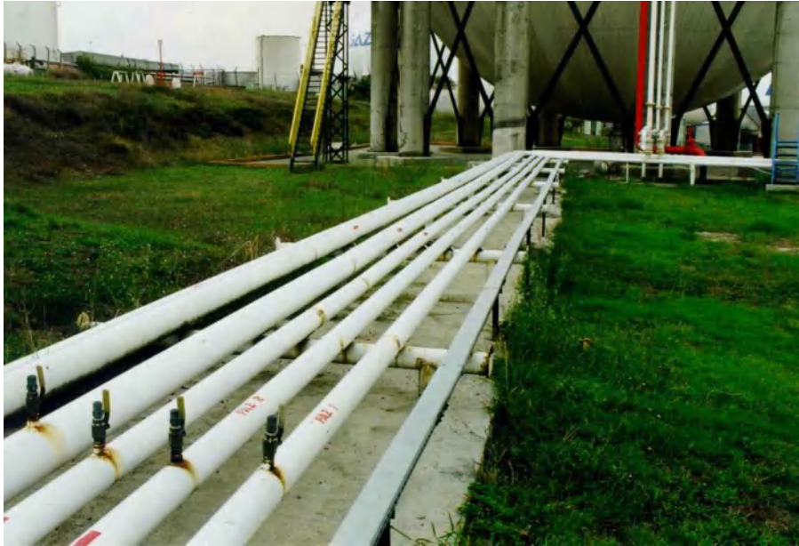
Figure 1-18 : Rack au sol, mission post-sismique AFPS d'Izmit (1999)
