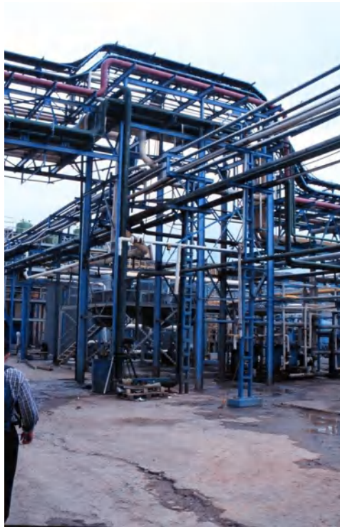
Figure 1-19 : Croisement de racks, mission post-sismique AFPS d'Izmit (1999)
