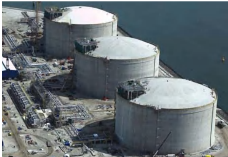
Figure 1-4 : Réservoirs verticaux posés au sol (TRACTEBEL)
