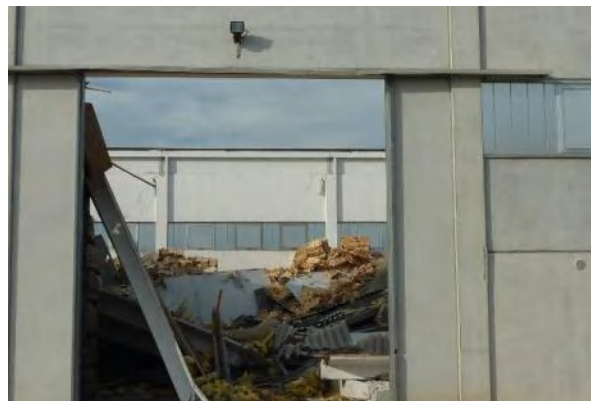
b/ Pannes simplement posées sur des poutres c/ Effondrement quasi-total des dalles de toitures
