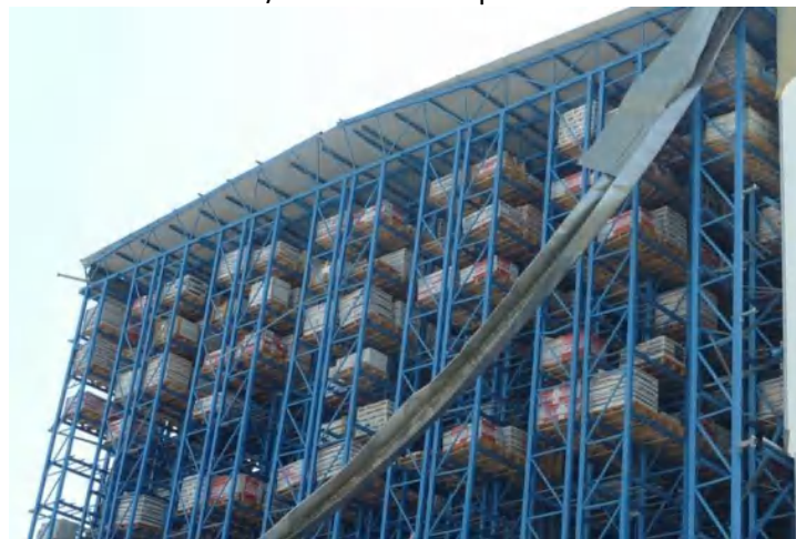
b/ Vue de la structure autoporteuse
