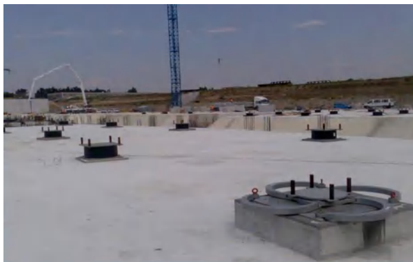
Figure 2-22 : Bâtiment stratégique sur isolateurs et dissipateurs d'énergie (Italie)
