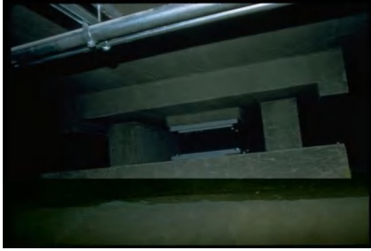
a/ Vue d'un isolateur sous la dalle de fondation
