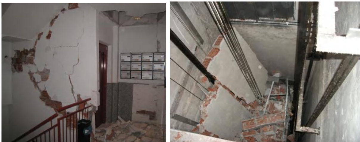
b/ Murs de remplissage en maçonnerie faisant office de cage d'ascenseur
