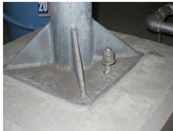
b/ Plastification de la tige d'ancrage
