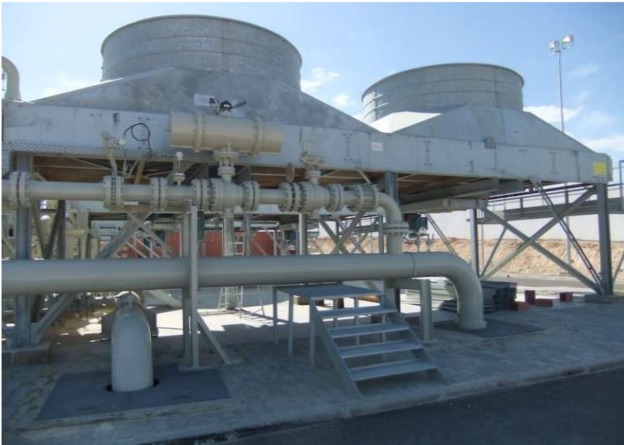
Figure 5.2 : Aéroréfrigérants [137c]
