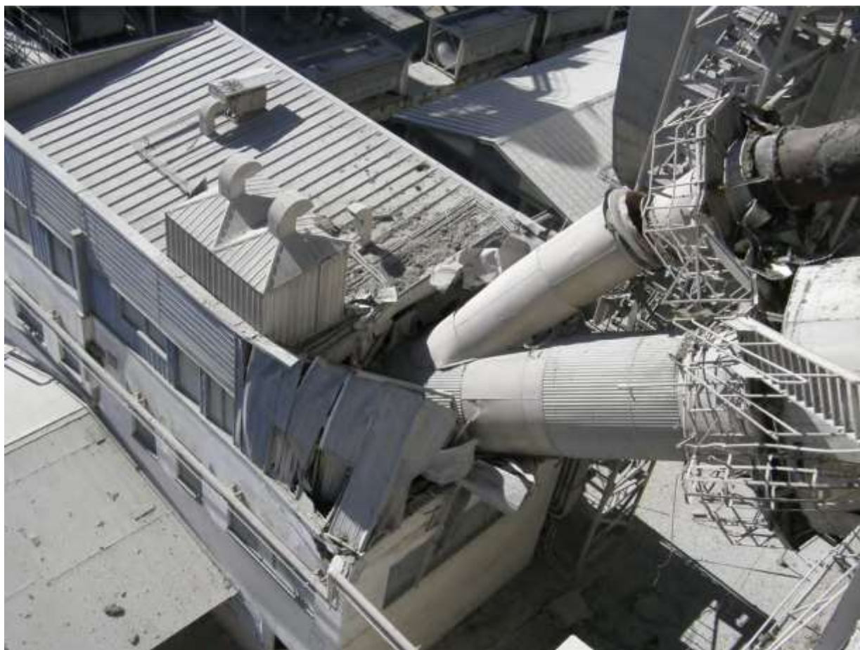
Figure 2.5 - Tour de refroidissement de cimenterie - Seisme de Maule, Magnitude 8.8, Chili 2010 [111]
